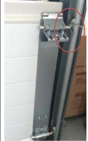
Antes de fijar la bisagra en el panel, separe el eje de la rueda, atornille la bisagra al panel luego fije el eje en la bisagra.
