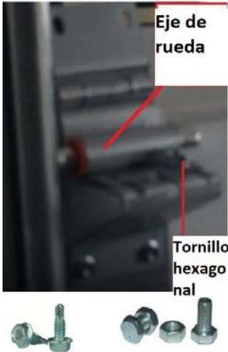
Colocando los paneles, controle la alineación en ambos lados desde abajo hacia arriba
